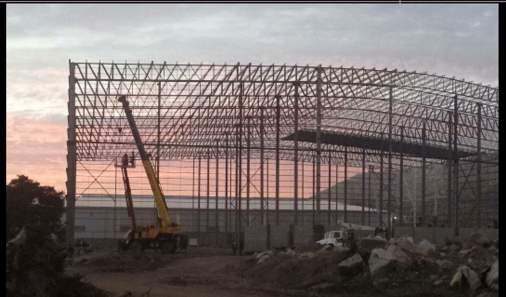
Proyecto: Nave industrial Ureblock-Tecate 8000 m2 (320 ton). Periodo: 2014-2015
