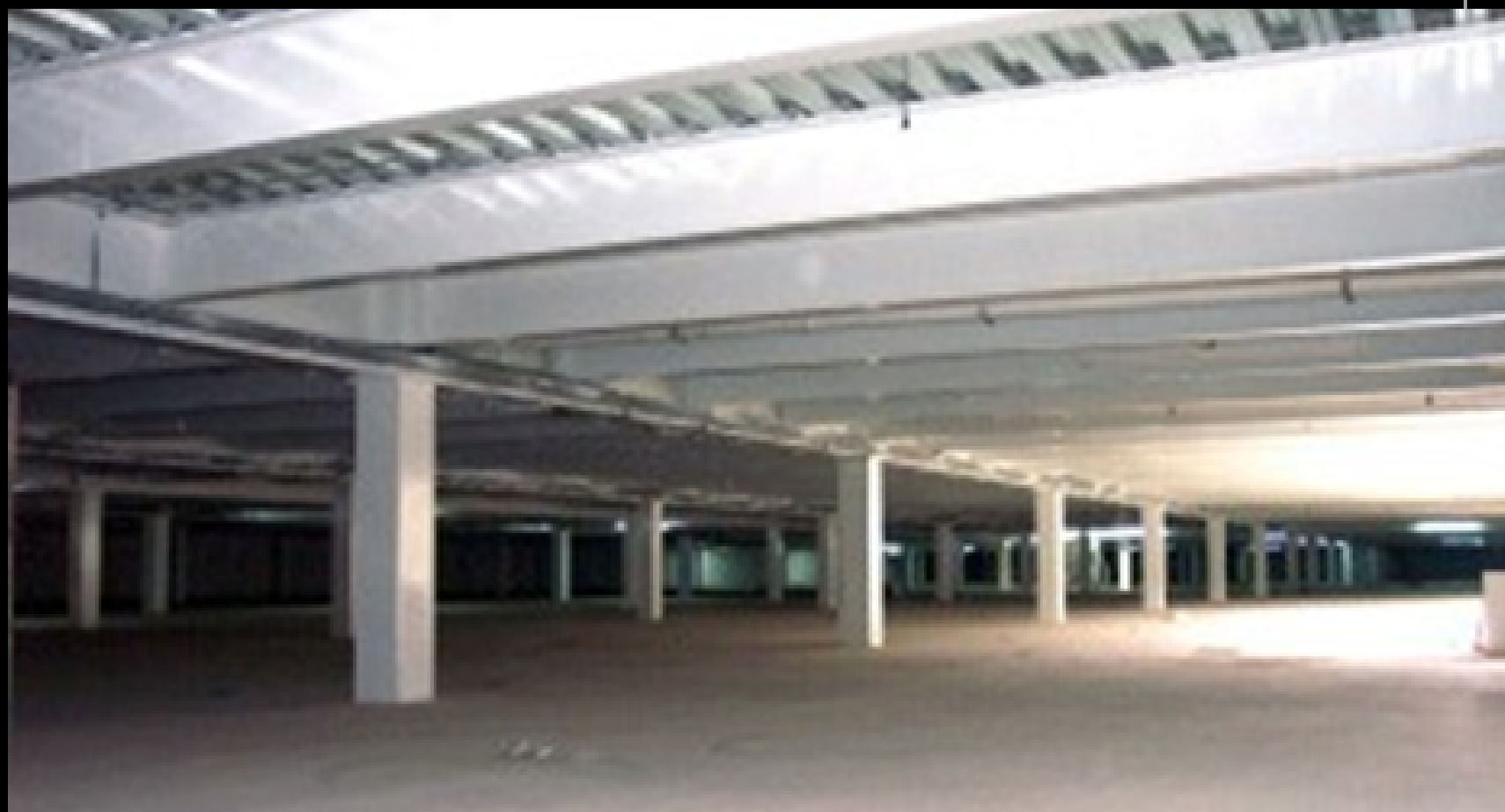
Proyecto: Central de abasto Viñedos San Marcos área de estacionamiento 22000 m2 Periodo: 2003-2004
