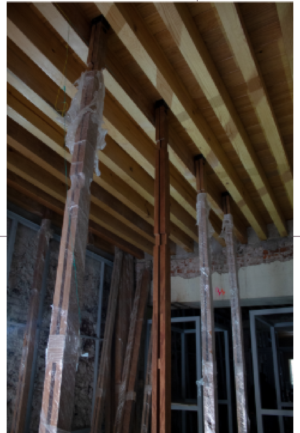
Vigas y tirantes de madera
