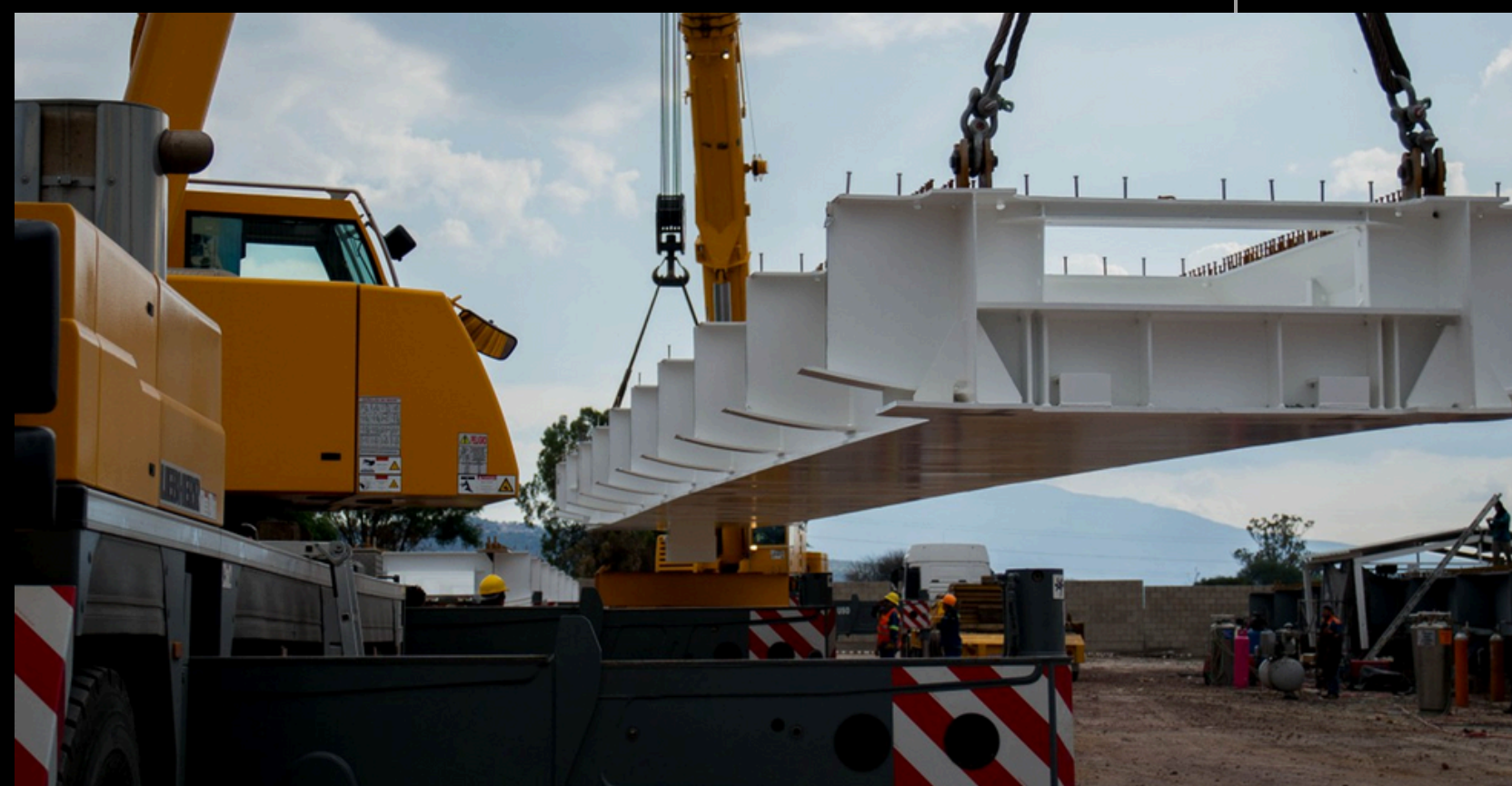
Proyecto: Viaducto elevado Tren Ligero Línea 3 Guadalajara (5000 ton) Periodo: 2015-2016
